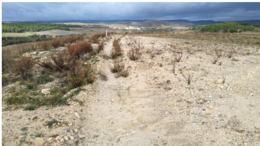
Figure 1 Diguette anti-ruissellement proche de la crête Ouest du toit du stock de Montredon
